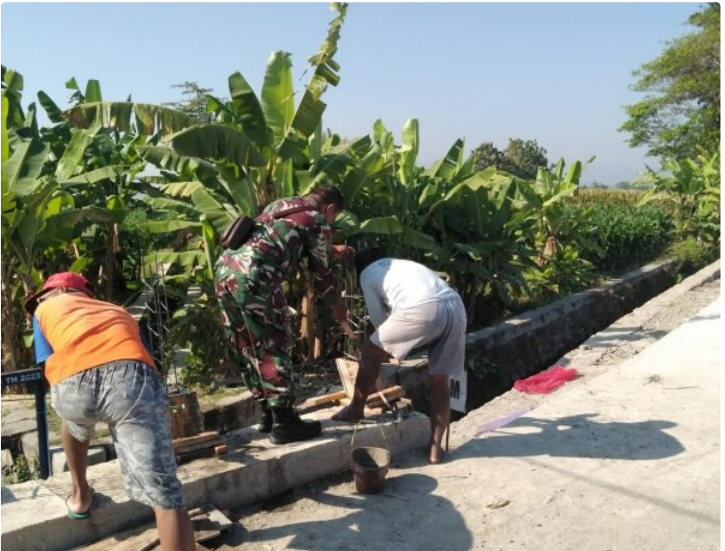
Tahap Finising Jembatan TMMD Reg 121 Kodim Klaten
