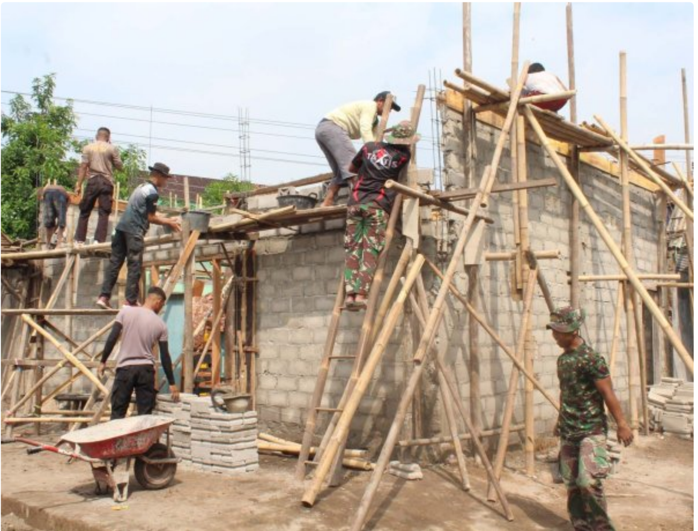
Satgas TMMMD Desa Tambong Wetan Juga Paham Konstruksi Bangunan
